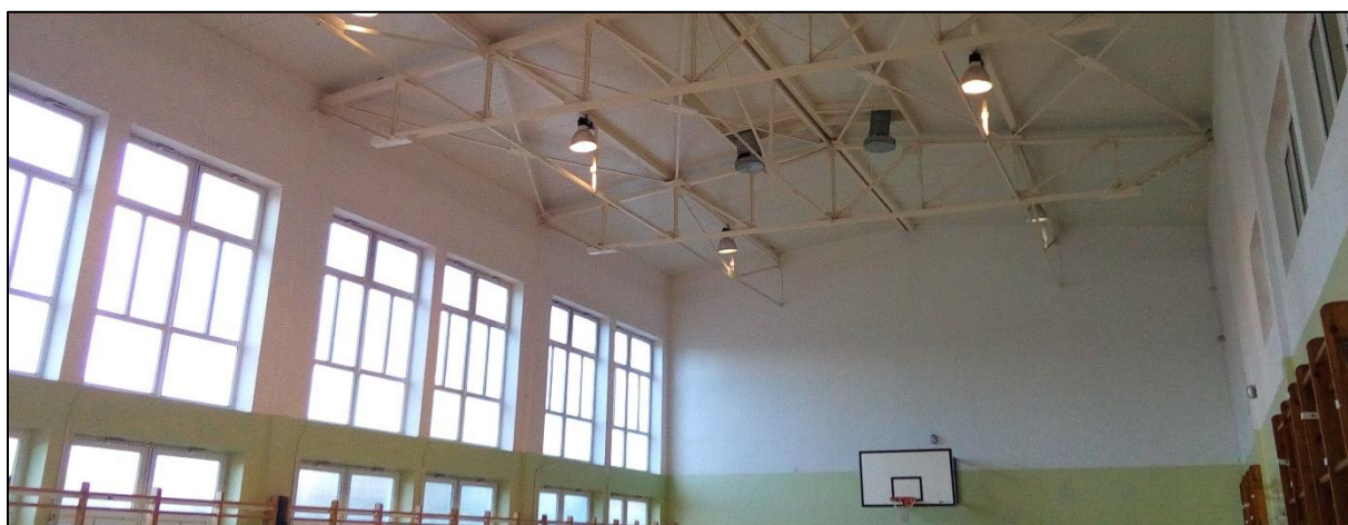
Rys. 129: Niezaizolowany sufit oglądanej hali sportowej
