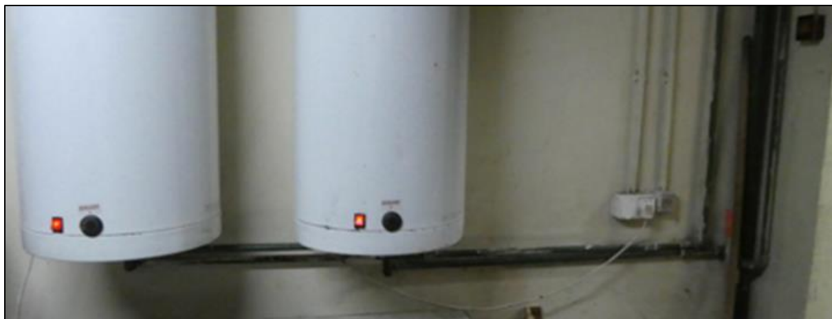
Rys. 113: Centralne ogrzewanie wody z niezaizolowanymi rurami w Domu Kultury w Hajnowce
