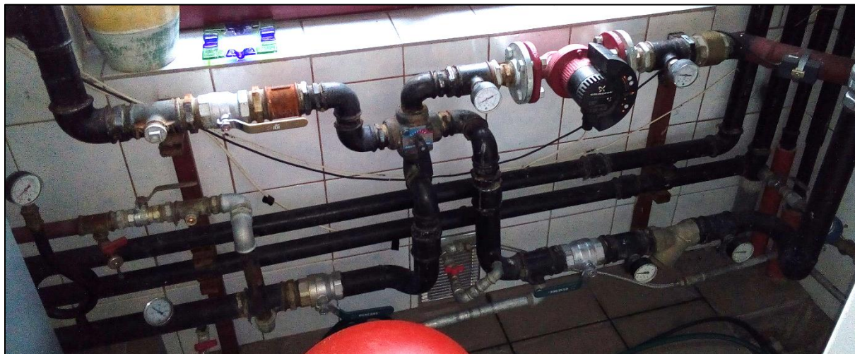
Rys. 122: Niezaizolowane rury grzewcze w kotłowni badanej nieruchomości
