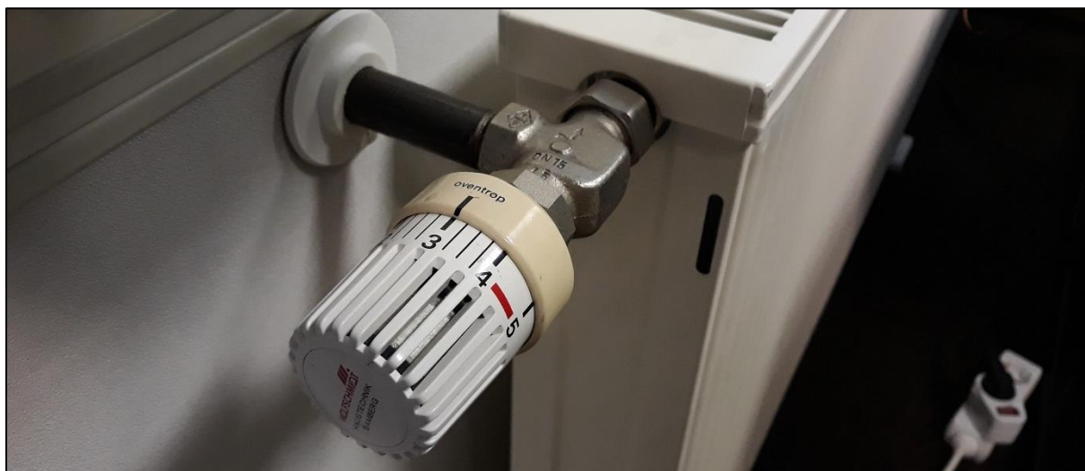
Rys. 126: Przykład regulowanego zaworu termostatycznego grzejnika
