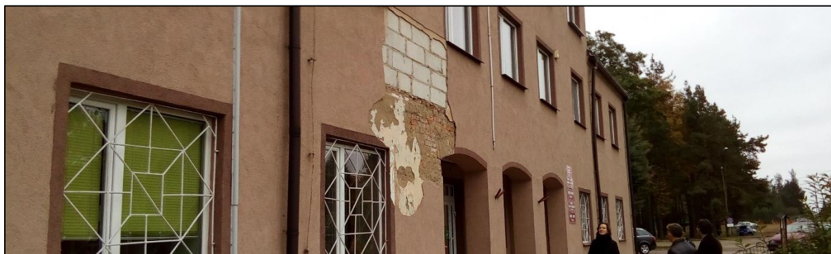
Rys. 117: Nieizolowane przegrody zewnętrzne budynku komunalnego
