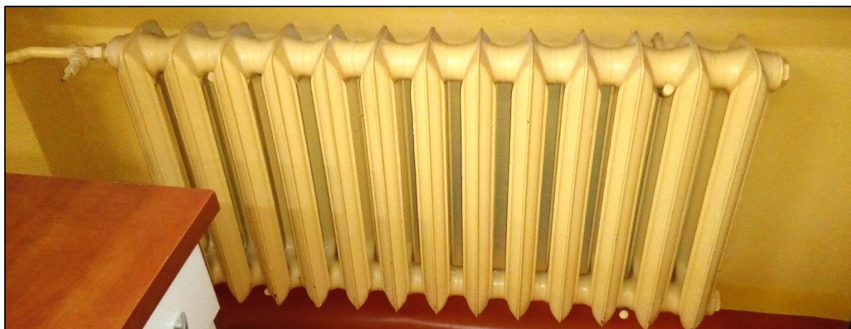
Rys. 124: Centralnie sterowany grzejnik bez własnego zaworu termostatycznego w jednej z oglądanych nieruchomości
