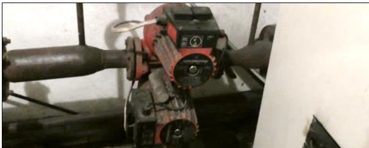
Rys. 112: Nieuregulowana podwójna pompa dystrybucyjna w Domu Kultury w Hajnówce
